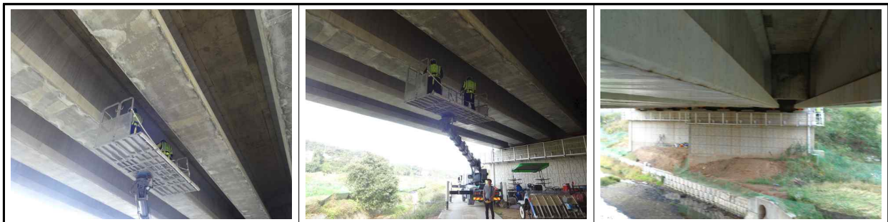
[고소작업차를 이용한 근접조사 실시]
