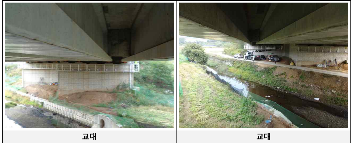
[교대 및 교각 전경]
